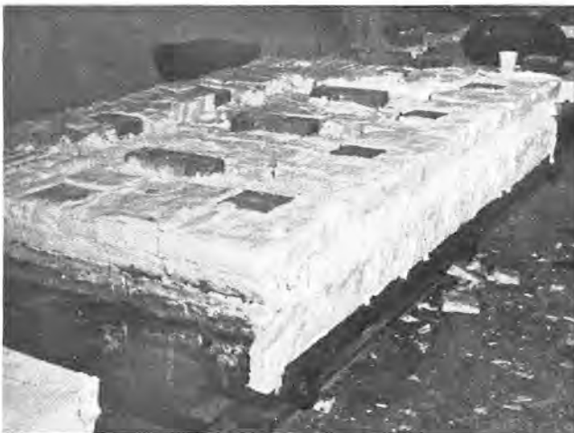
Fig. 4: Un carrito de horno durante su construcción, antes de que le fueran colocados en la parte superior ladrillos refractarios densos. La manta de fibra cerámica proporciona aislamiento adicional al tren articulado del carrito, y en los laterales, confiere un cierre estanco fibra-fibra con los cierres estancos de tipo banco del horno.
